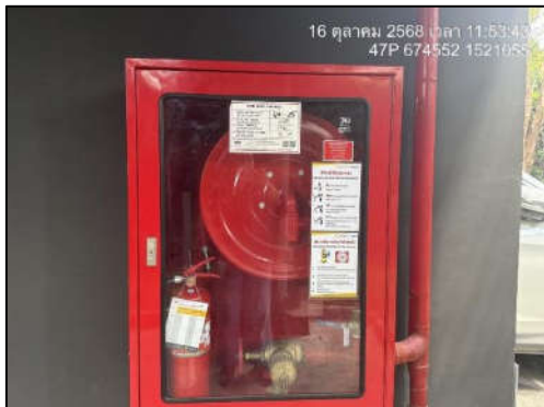
รูปที่ 26 ตู้ดับเพลิง Fire Hose Cabinet (FHC)
