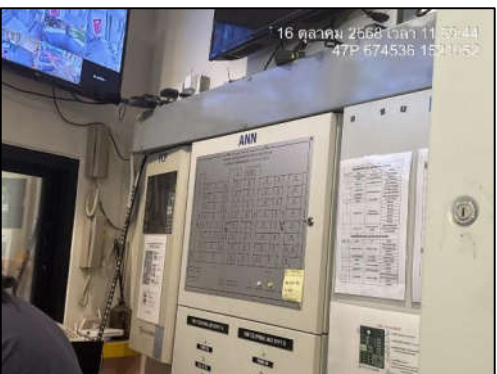
รูปที่ 23 (ต่อ) ระบบส่งสัญญาณและแจ้งเหตุเพลิงไหม้
