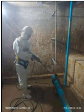
รูปที่ 11 (ต่อ) ล้างทำความสะอาดถังสำรองน้ำใต้ดิน
