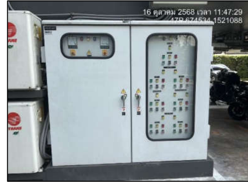
รูปที่ 9 ตู้มิเตอร์และควบคุมระบบบำบัดน้ำเสีย
