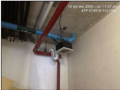
รูปที่ 16 ระบบระบายอากาศห้องพักขยะเปียก
